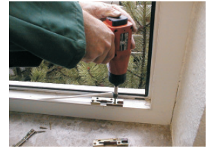
4) Rahmentteile einbauen und Beschlag fetten
