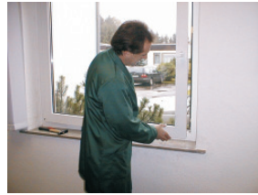
3) Flügel einhängen und einstellen
