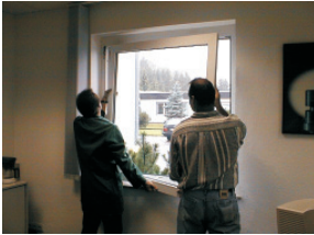
1) Flügel aushängen Rahmentteile ausbauen
